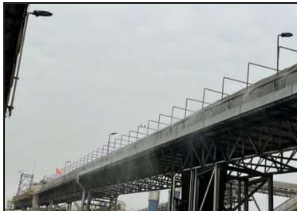
รูปที่ 2-20 ระบบสายพานลำเลียงแบบปิด
