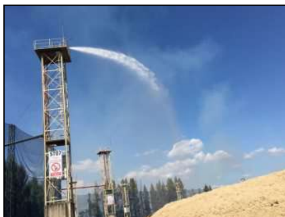
รูปที่ 2-10 ระบบน้ำสปริงเกอร์
