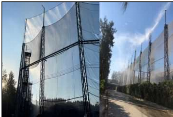
รูปที่ 2-12 ตาข่ายรอบลานกองเก็บเชื้อเพลิง
