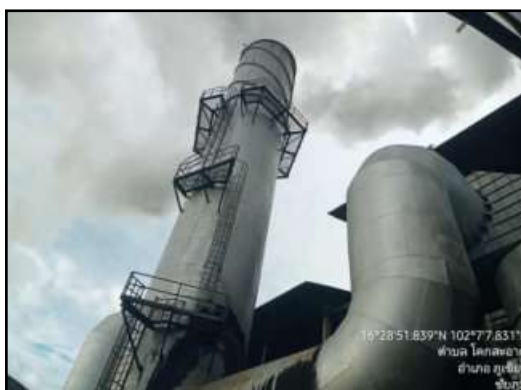
Block 3 (ระบบดักฝุ่นแบบ multicyclone ต่ออนุกรมกับ Wet scrubber)
