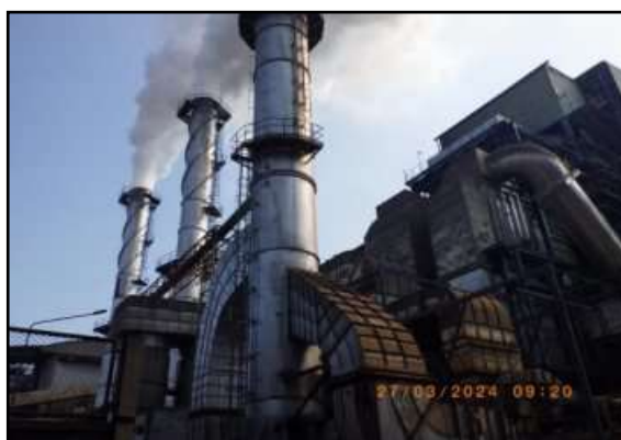
Block 2 (ระบบดักฝุ่นแบบ Wet scrubber)
