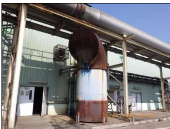
รูปที่ 2-37 ระบบไซเรนเซอร์
