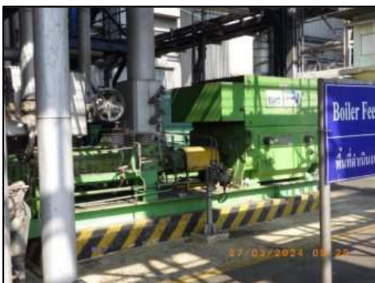
เครื่องสูบน้ำป้อนหม้อไอน้ำ
