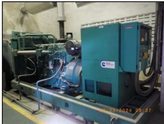
รูปที่ 2-47 เครื่องกำเนิดไฟฟ้าสำรอง
