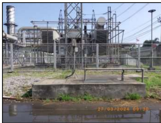
รูปที่ 2-34 ระบบถังแยกน้ำและน้ำมัน (Oil Separator)
