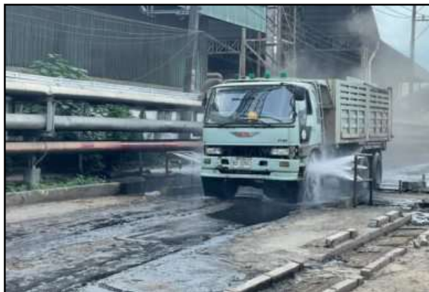
รูปที่ 2-24 พื้นที่ล้างล้อรถบรรทุก
